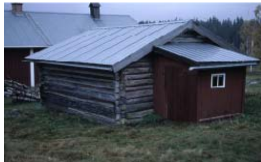
Vedbod och dass. Mot norr.
