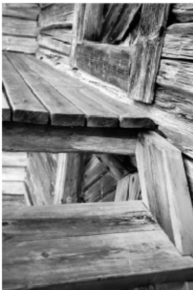
Tryckimpregnerat virke i svalgången.
